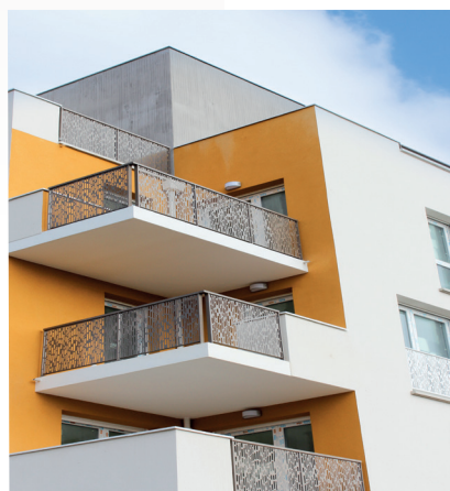
Résidence en cours de construction à Melun (77)
