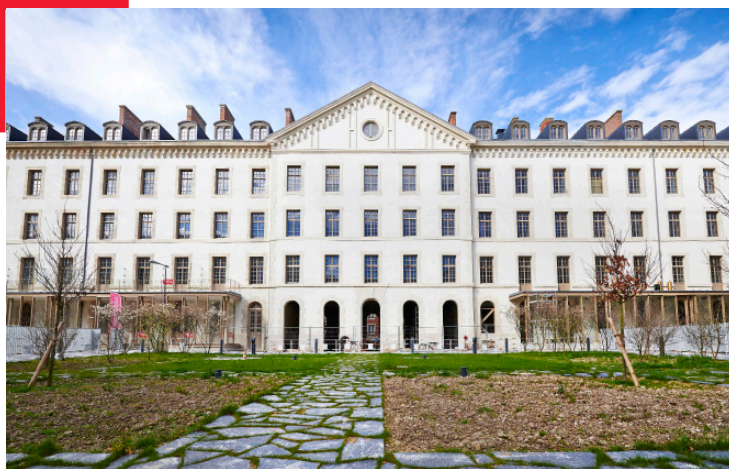
#1 : Le bâtiment d'origine (rue Ponsardin)
